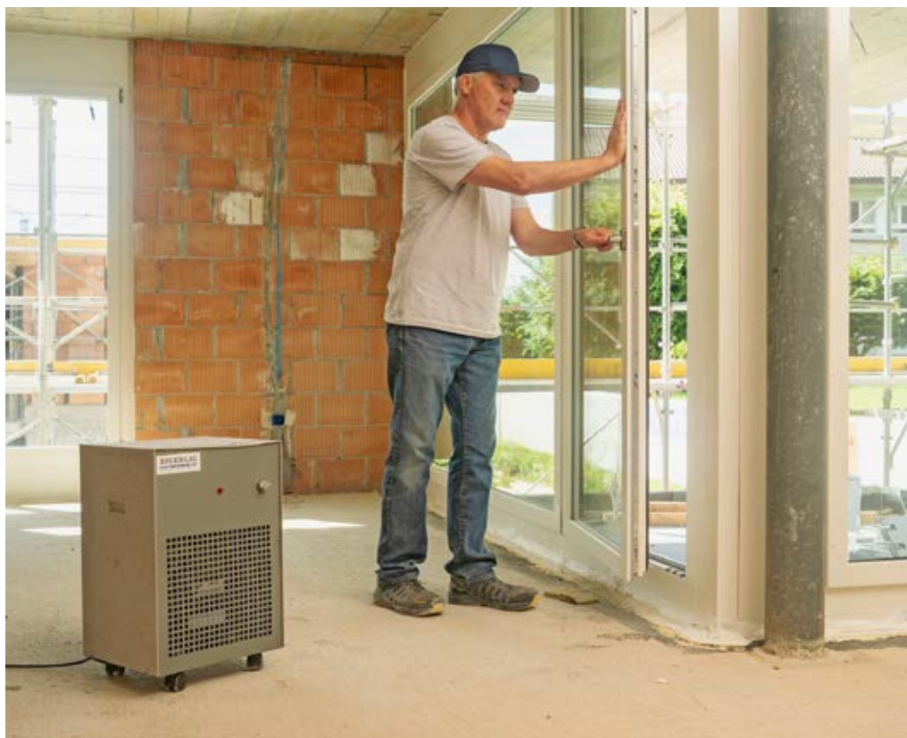
Gut geschlossene Türen und Fenster vermeiden, dass feuchte Aussenluft in den Raum dringt und so einen unnötigen Stromverbrauch bewirkt.
