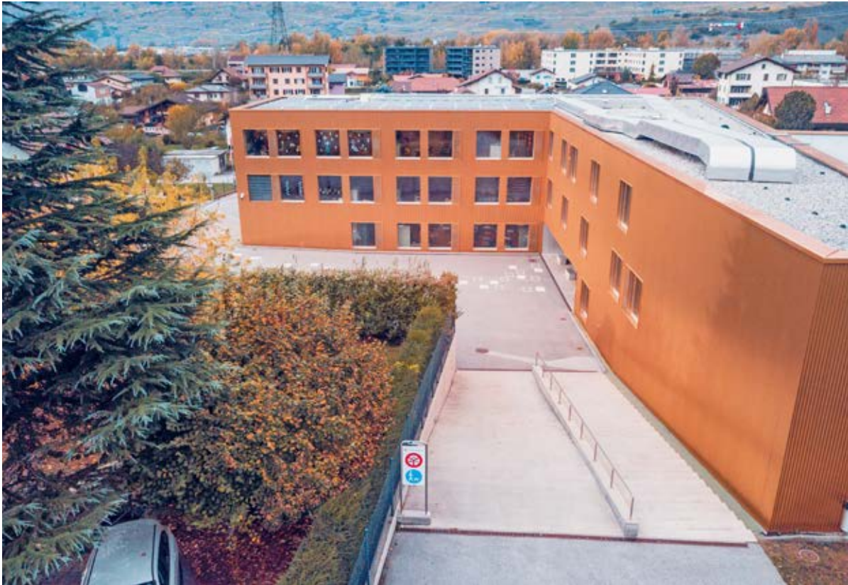
La commune de Nendaz a pu réduire la consommation d'énergie du centre scolaire d'Aproz de 35%.
